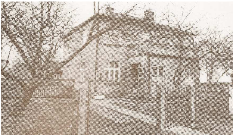
Jelgavas 2. septiņgadīgā skola - Brīvības bulvāris 31
