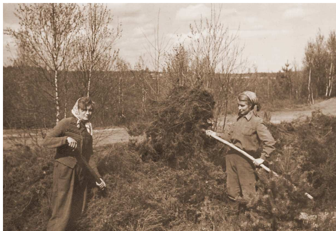
Viršu vākšana ceļa būvei 1959. gads
